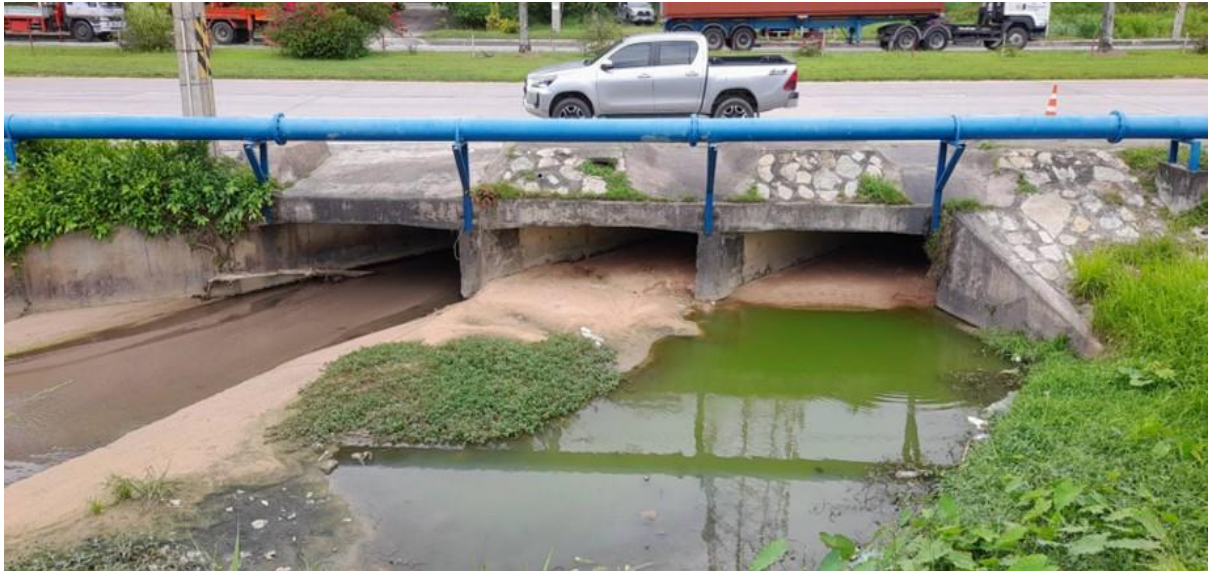
ภาพก่อนดำเนินการขุดลอกตะกอนในรางระบายน้ำฝน
